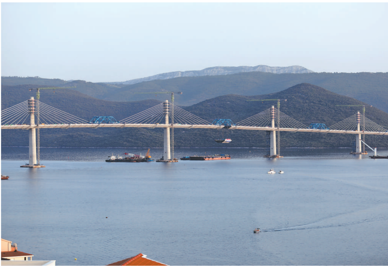
当地时间7月28日，随着中国建设者用桥面吊机把最后一块重达220吨的钢箱梁提升到位并完成焊接，中国企业承建的克罗地亚佩列沙茨跨海大桥成功合龙。佩列沙茨大桥是一座长2440米、宽22.5米的公路斜拉桥，横跨克罗地亚南部亚德里亚海的小斯通湾，连接该国大陆与佩列沙茨半岛。
