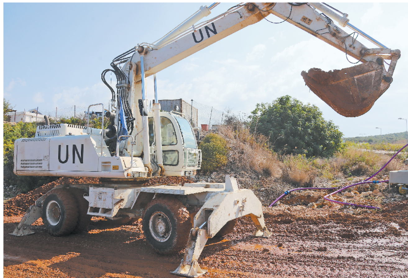
我第19批赴黎维和建筑工兵分队,近日完成应黎部队司令部请求展开的道路疏通任务。黎黎部队司令部营区多处地段因暴雨发生山体滑坡,数条主干道被泥石流堵塞,严重影响了各国维和部队的工作和出行。图为我维和官兵利用机械清运碎石泥土。 黄礼明摄
