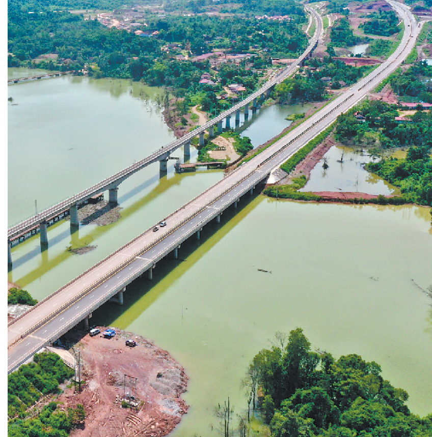
中老高速公路项目第一期万象至万荣段(简称“万万高速”)正在进行运营前期准备,建成后将成为老挝第一条高速公路。图为近日在老挝万象省航拍的万万高速桥梁(右)和中老铁路桥梁(左)。 新华社发
