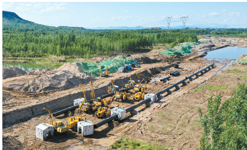
中俄东线天然气管道工程起自俄罗斯东西伯利亚,由布拉戈维申斯克进入我国黑龙江省黑河。中俄东线天然气管道将与我国现有区域输气管网互联互通,向沿线地区稳定供应天然气资源。图为6月4日,工人在河北省滦州市油榨镇境内的滦河河床上进行中俄东线天然气管道工程(长岭-永清)第八标段施工。 新华社发
